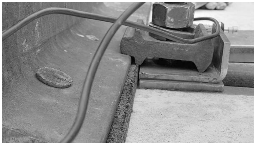
Obr. 3 Detail vybraného tuhého uzlu upevnění.
