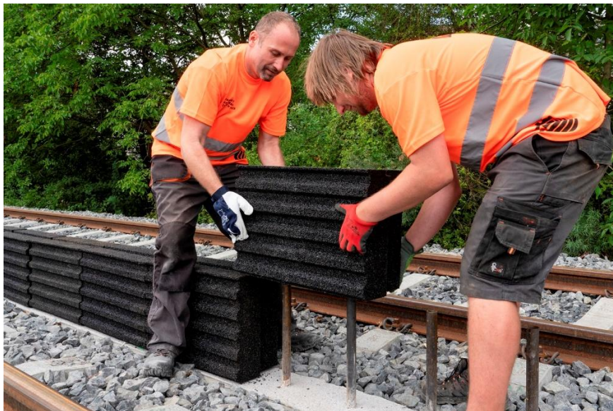
Obr. 1 Výstavba MPHC v lokalitě Praha Hloubětín.
