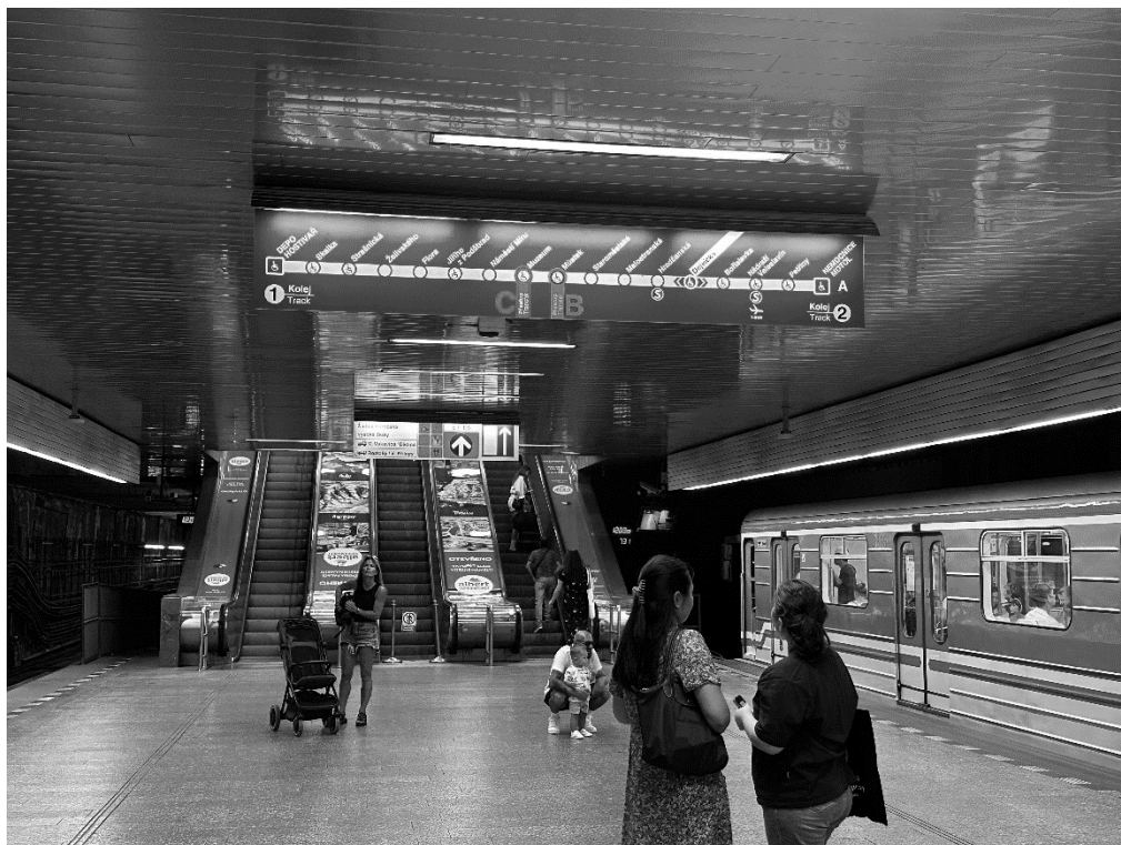
Obr. 6. Koncepce nasvětlených nosičů „vlaštovek“ používaných po r. 2002. Konkrétní nosič je nasvětlen třemi zářivkovými tělesy, na fotografii jsou patrná tmavší místa v oblasti styku patič zářivkových těles. Stanice Dejvická, foto z archivu autorů
