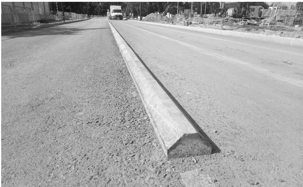
Obr. 6. Opracovaná kamenná obruba OP4 s fazetou 7x7 cm použitá jako podélný oddělovací práh
