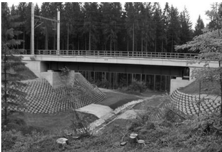
Obr. 2. Podchod pro migrující zvěř [2]
