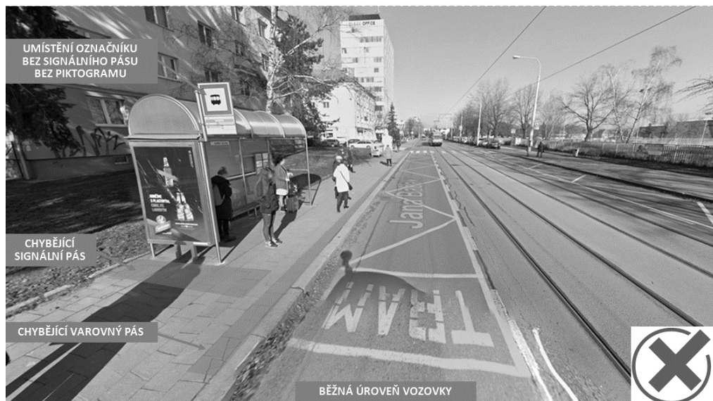
Obr. 2 Příklad špatného stávajícího řešení nebezpečné zastávky Tererova (směr do centra) s nástupem/výstupem do vozovky.
