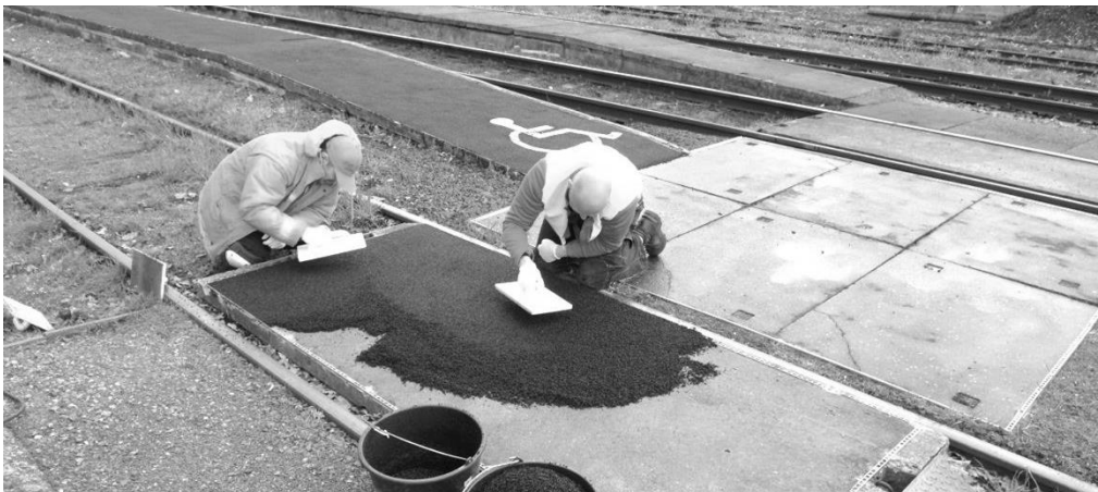
Obrázek č. 4 – Úprava nástupiště a přístupu ve stanici Sušice
