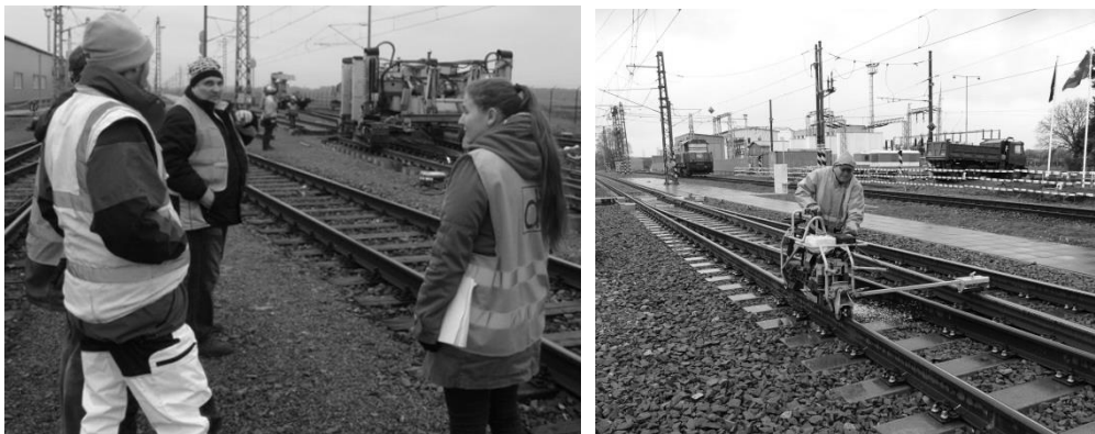
Obr. 5. Pokládka a základní broušení v. č. 1 a č. 2 na VZO Velim
