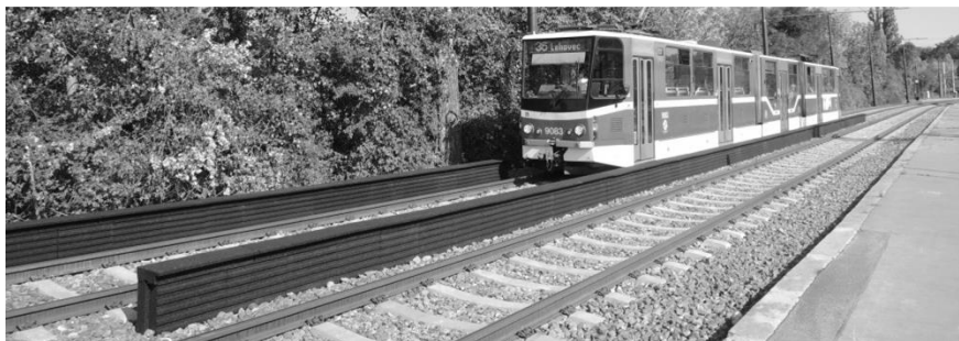
Obrázek č. 3 – Úsek tramvajové trati s Městskou protihlukovou clonou
