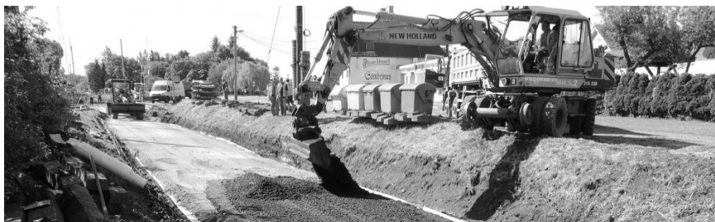
Obrázek č. 3 – Výstavba zkušebního úseku ve Štáhlavech
